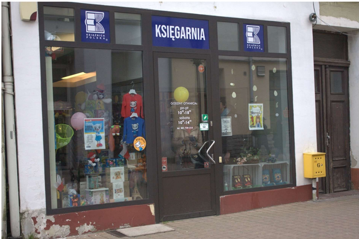
Fot. 8. Zaniedbane lokale użytkowe na obszarze rewitalizacji – deptaku miejskim
