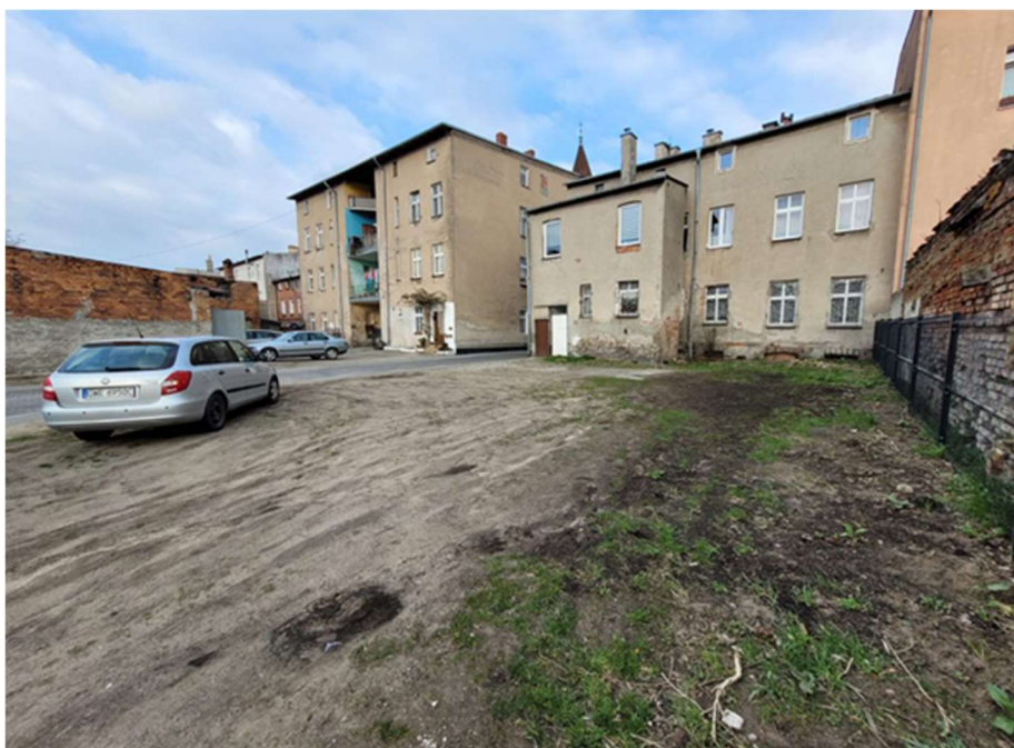
Fot. 18. Niskiej jakości przestrzeni półpubliczne – podwórka na obszarze rewitalizacji
